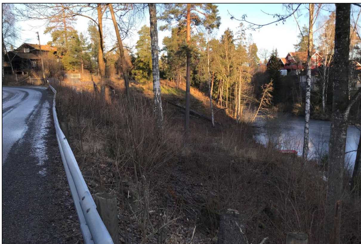
Figur 3. Tomta er lokalisert mellom to små tjern i en forholdsvis bratt skråning på østsiden av Granveien. Foto: Bjarne Homnes Oddane
